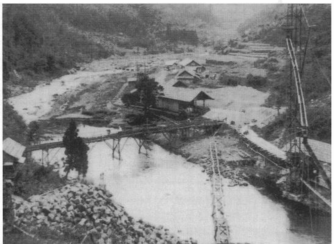
築造前の白水ダム付近
